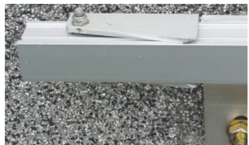
Flügelsicherung als Endstopp / Blade safety device as end stop
