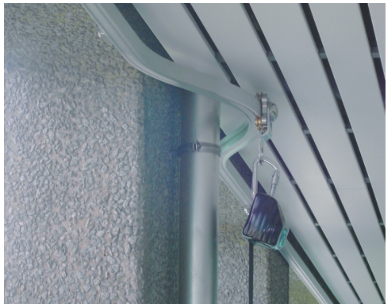
Horizontalsystem mit Bogen / Horizontal system with bend
