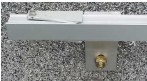
Schiene mit Halterung und Endstopp / Rail with mounting and end stop
